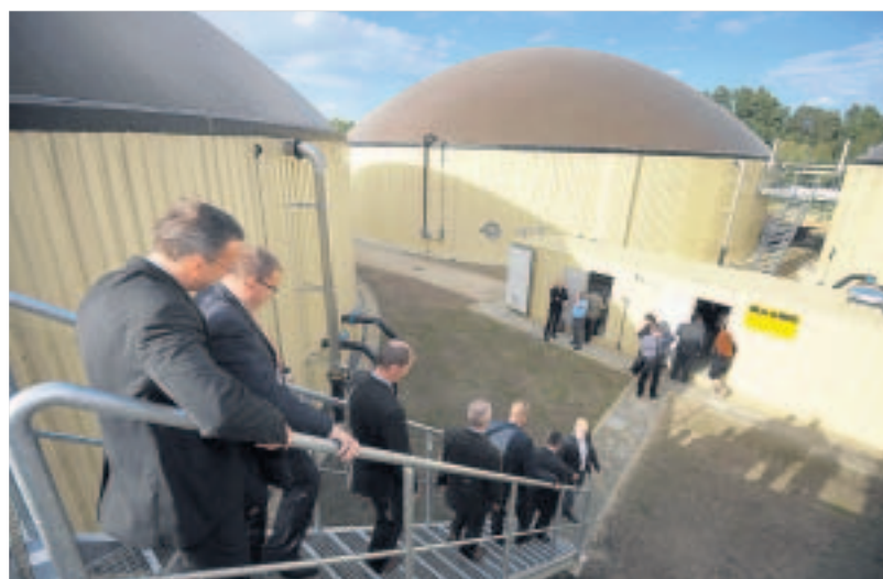
Acht Fermenter, die wie halbe Kugeln aussehen, gehören zu der Anlage.
